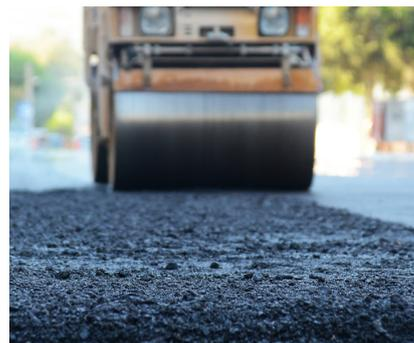
Le opere previste comprendono la fresatura della pavimentazione stradale, scavi a sezione ristretta, adeguamento dei chiusini, asfaltature, realizzazione della segnaletica orizzontale e completamento di sistemazioni accessorie.
