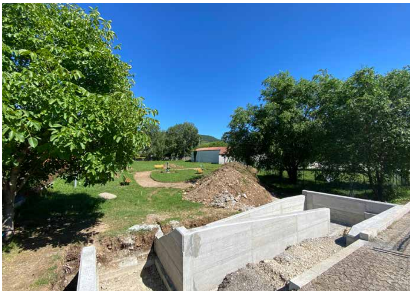
I lavori di sistemazione dell'area fitness in viale Caduti del Lavoro
